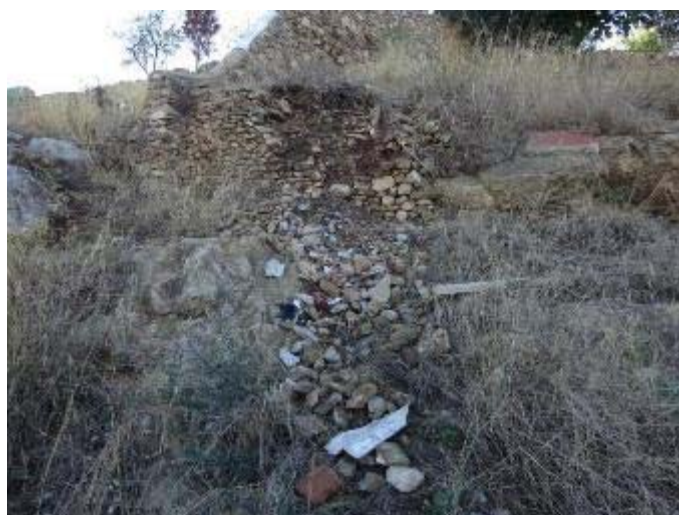
Figura 28: enderroc del mur d'aterassament.
