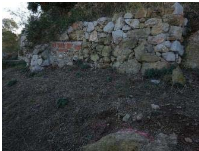
Figura 16: àrea de la rasa 8 abans d'efectuar la intervenció.
