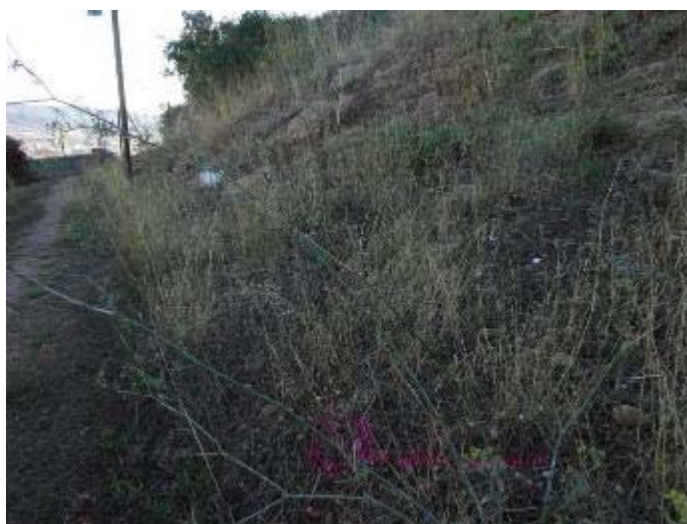
Figura 17: àrea de la rasa 9 abans d'efectuar la intervenció.
